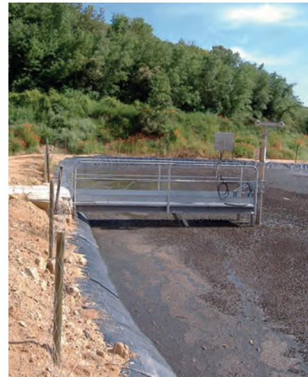
**SOPORTE PARA BALSAS TALUD DE PVC SUSPENDIDA**
